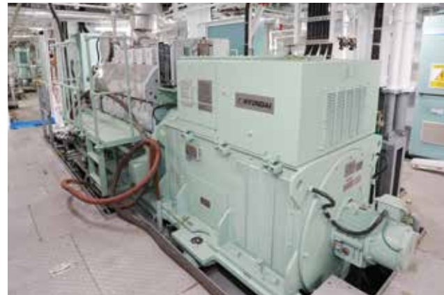
▲ 발전기 Main Diesel Generator
