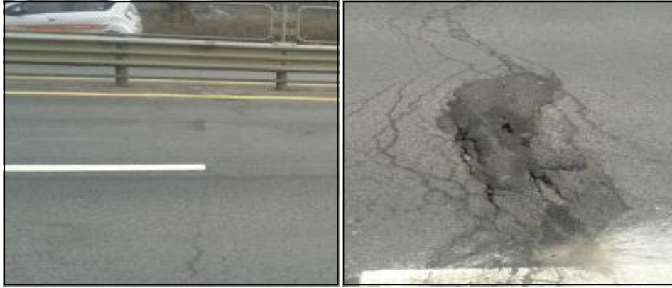
[그림 III-14] 박리방지제 적용(왼쪽사진)과 적용하지 않은(오른쪽사진) 동일 장소 비교
