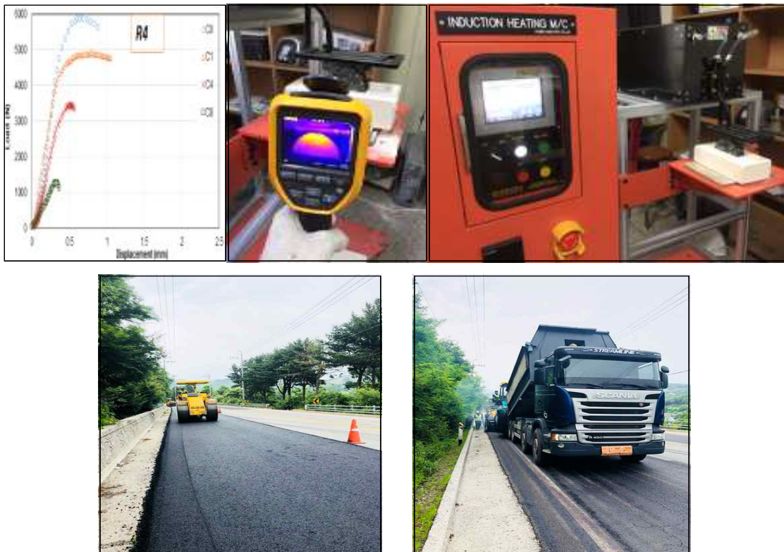
[그림 III-2] 자기치유 아스팔트 포장 실증화 적용 현장(익산지방 국토관리청)
